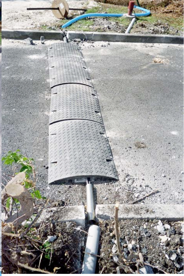
Illustration de l'installation sur site. En haut à gauche : l'armoire de commande avec la centrale d'acquisition ; en haut à droite : le capteur de surface ; en bas à gauche : le passage des câbles au niveau des têtes de forage ; en bas à droite : les passe-câbles au niveau de la chaussée.
