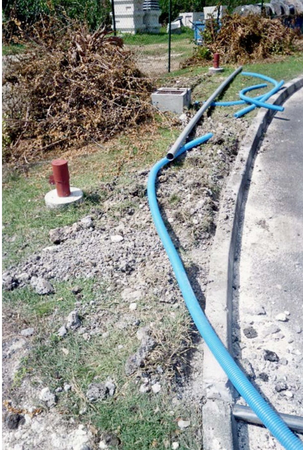
Illustration de l'installation sur site. En haut à gauche : l'armoire de commande avec la centrale d'acquisition ; en haut à droite : le capteur de surface ; en bas à gauche : le passage des câbles au niveau des têtes de forage ; en bas à droite : les passe-câbles au niveau de la chaussée.
